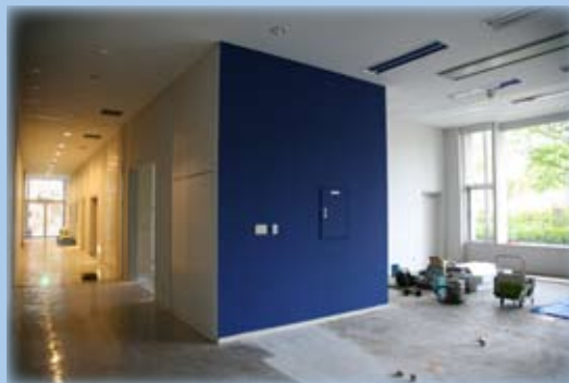
現在、工事中の「学生プラザ」
