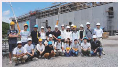
ひびきの小学校建設現場にて
