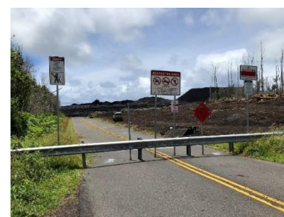
キラウエア火山の溶岩流で被災した住宅地
