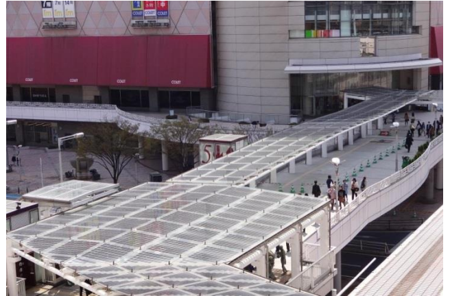
写真1 小倉駅ペDESTリアンデッキ「太陽光パネル」～完成したコレット側
