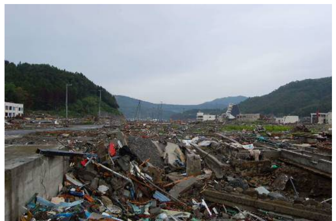
写真2 建物が破壊し尽くされた市街地（旧雄勝町）
