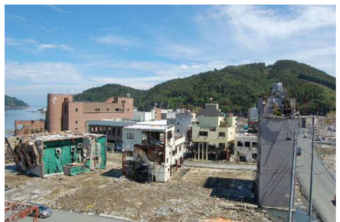
写真3 横倒しになった建物（女川町）
