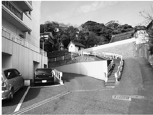
南部町マンション COOP 下関からの斜面 便利のいいマンションから1段上がると車が入らない斜面地になる
