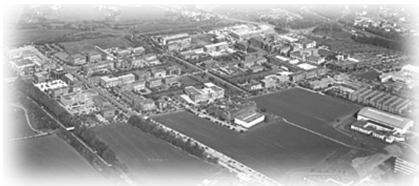
テクノロジーパークの全景
