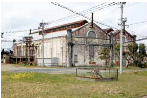
写真1 遠賀川水源ポンプ室 (中間市)
