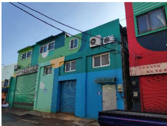
〈図 8〉 壁面がえがけられた工場
