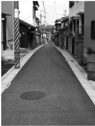
写真1 舗装の修繕例
