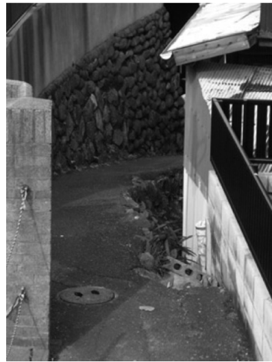
写真2 手すりの未設置例
