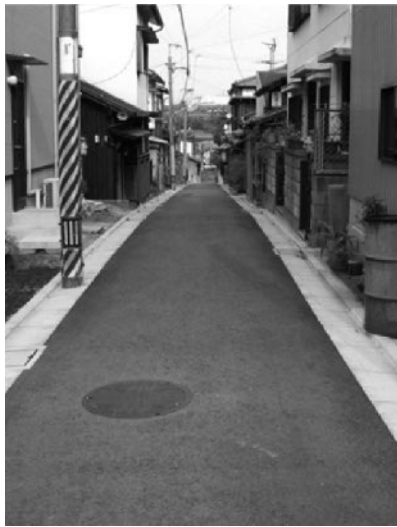
写真1 舗装の修繕例
