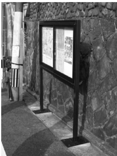
写真3 掲示板の設置例
